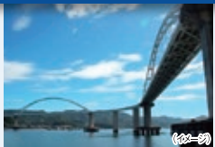
下から見る内海大橋
