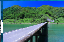
名越屋沈下橋
